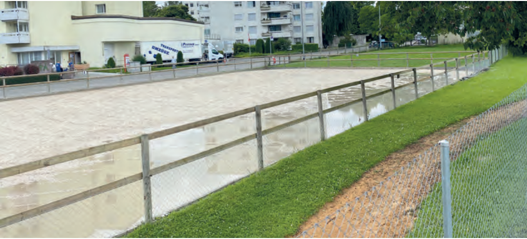
Der Trainingsplatz des RV Amriswil und Abreitplatz des Osterspringens muss saniert werden.
